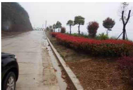
连接区道路右侧排水沟
