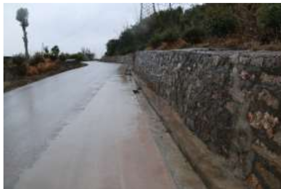
连接区进场道路入口右侧挡墙
