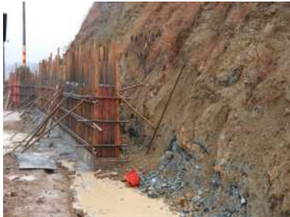
连接区挡墙施工
