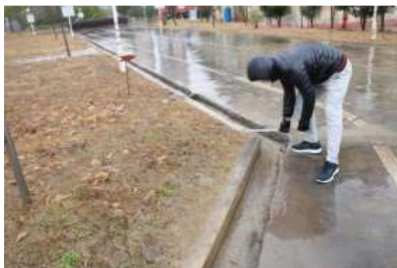
汽车散发库南道路旁排水沟
