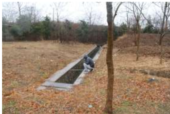
厂区南侧浆砌石排水明沟
