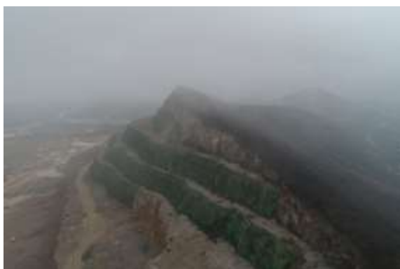
航拍密目网苫盖
