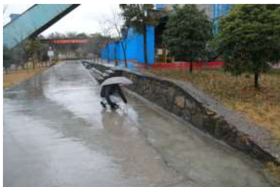
熟料库西侧挡墙
