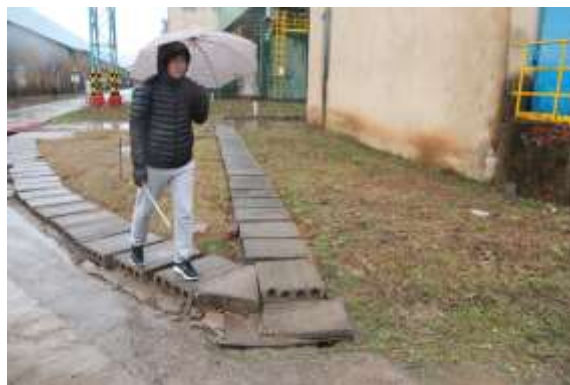
厂区西侧砼盖板排水沟
