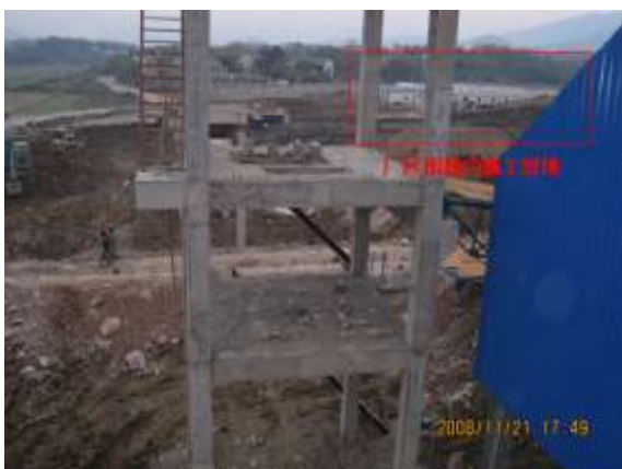
厂区建筑物施工
