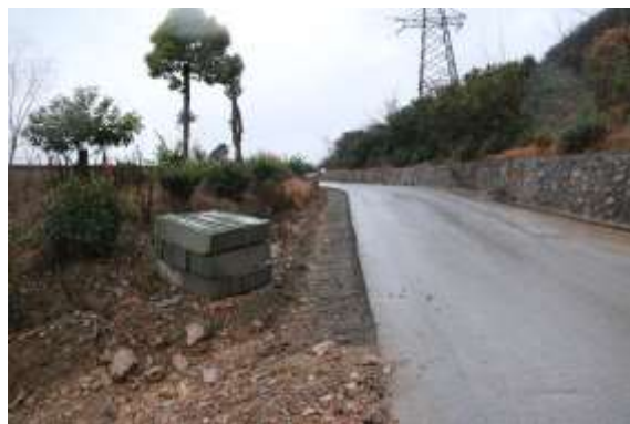
进场道路路沿排水沟施工
