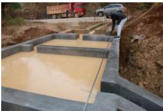
进场道路中段砖砌沉砂池
