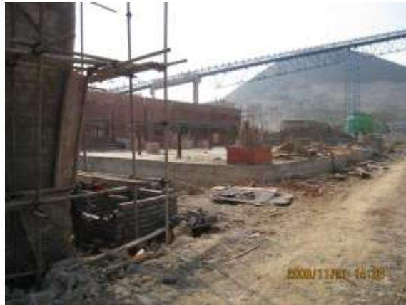
厂区建筑物施工
