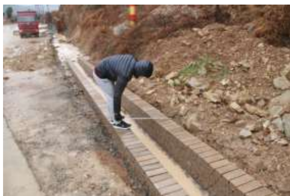
连接区道路左侧排水沟
