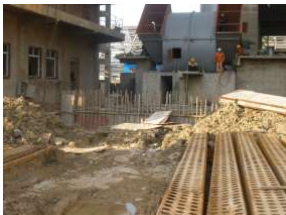
厂区建筑物施工
