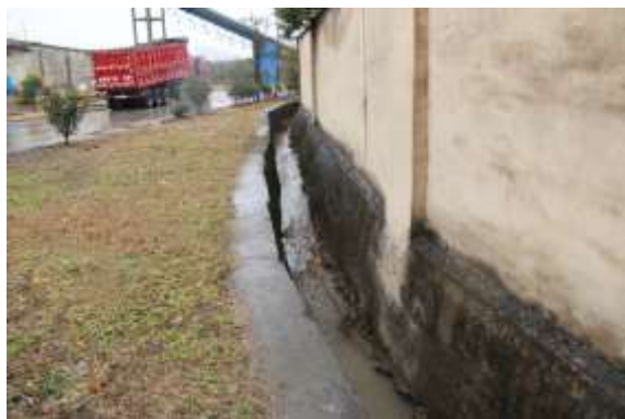
厂区北侧墙内排水明沟
