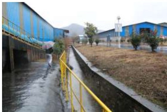
堆煤区排水明沟
