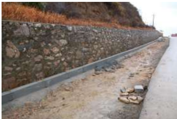
连接区进场道路中段左侧挡墙
