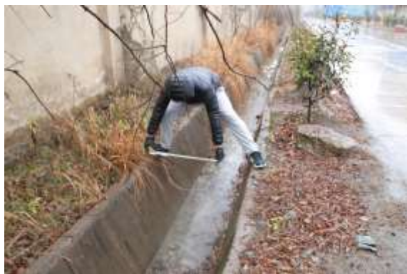
厂区砼预制块排水沟
