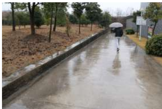
食堂东侧挡墙
