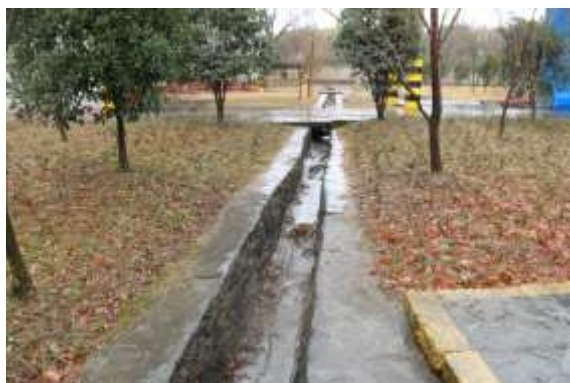
熟料库东侧浆砌石排水沟
